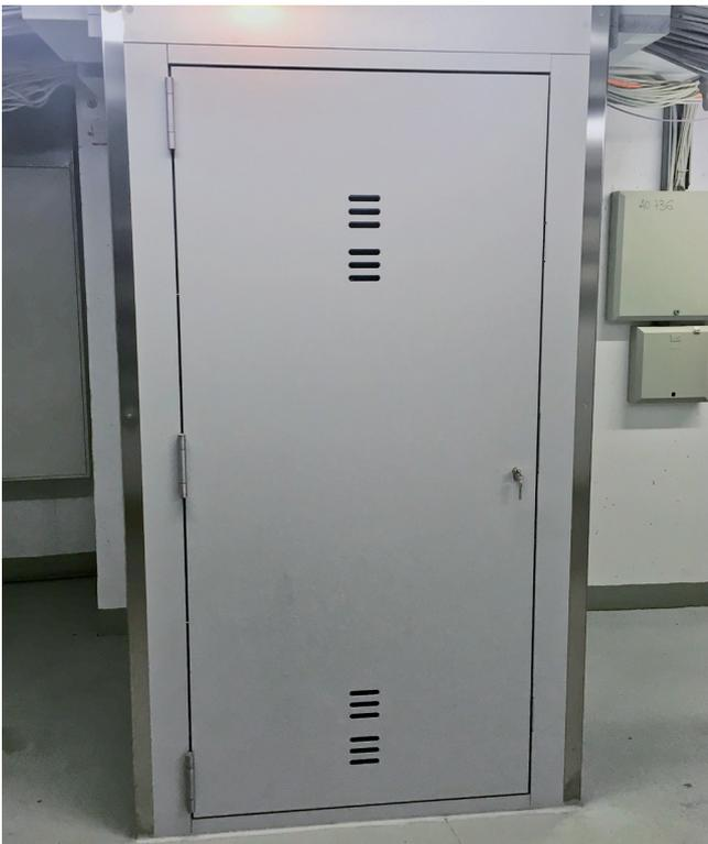
Feuerwiderstandsfähige Einhausung mit Belüftungsöffnungen
